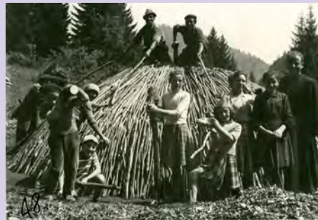
La costruzione del poiât [Arch.B]
